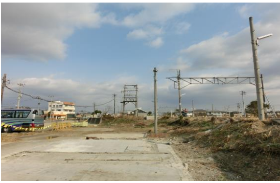
無くなった山下駅駅舎
